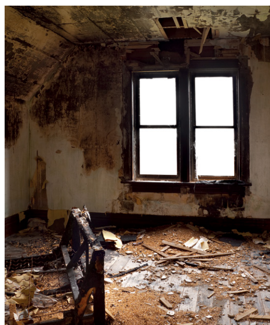
Tommelfingerreglen er: dine ting - din forsikring
